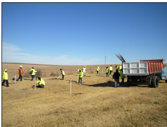
Cuadrillas de mantenimiento realizando labores de reposición.
